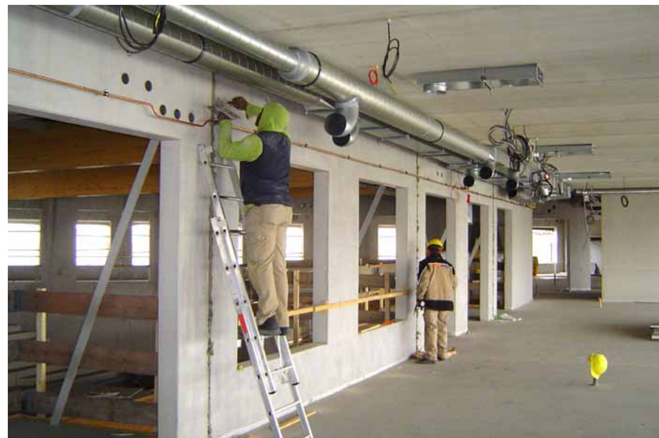
Aan de binnenzijde krijgt het gebouw een open structuur.
