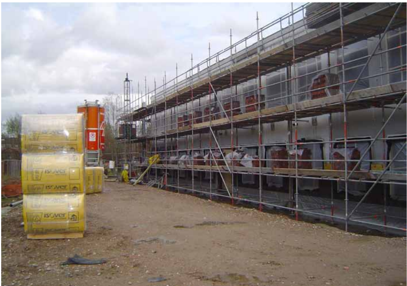
Isolatiewerkzaamheden aan het nieuwe schoolgebouw.
