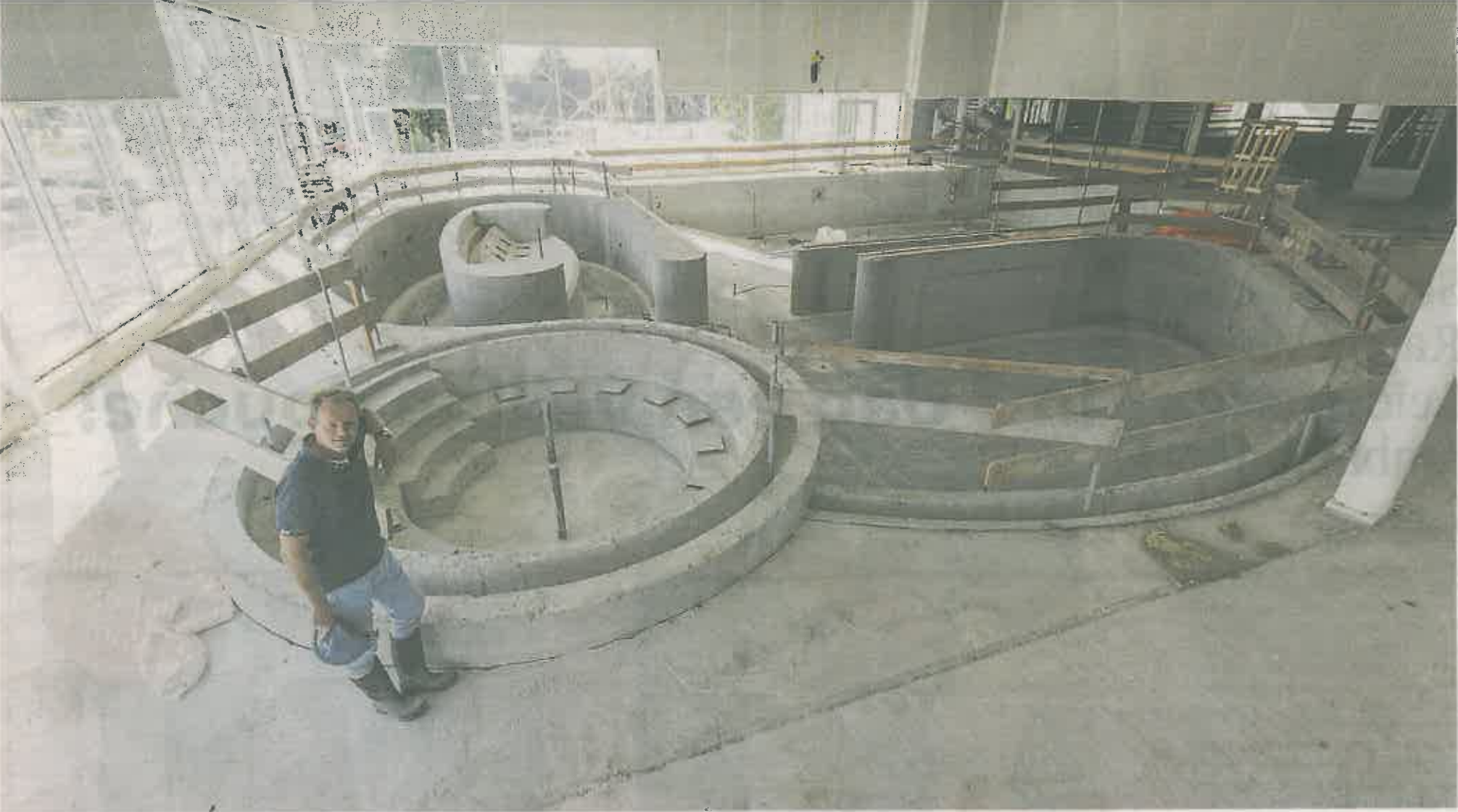
Fred van Trigt bij het recreatiezwembad in aanbouw. „Een officiële ingebruikname in februari volgend jaar moet volgens de huidige planning haalbaar zijn.”
