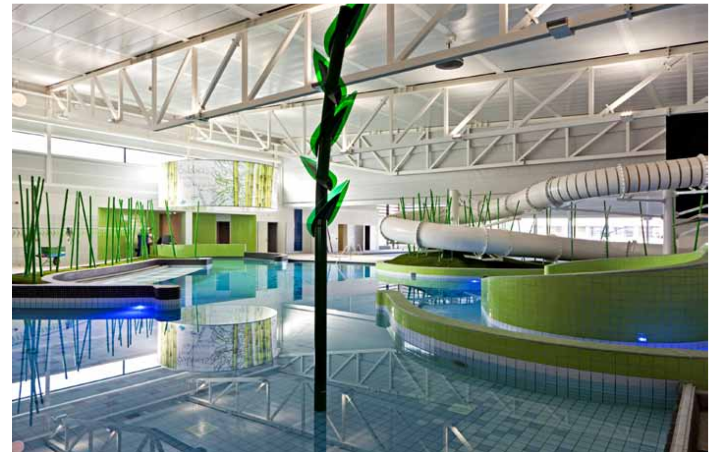
Staalconstructie op onderbouw van beton.
