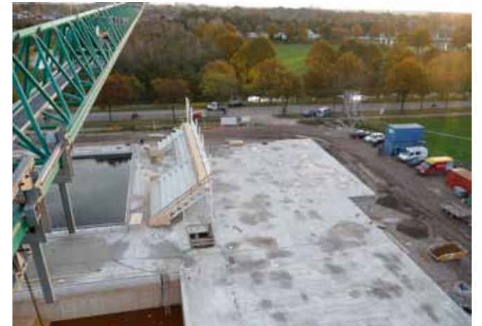
Foto's links: De badkuipen zijn in-het-werk gestort. Boven: Staalbouw volgde betonbouw nauwgezet. Onder: Prefab tribune-elementen.
