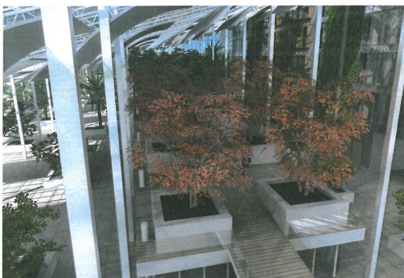
Nederlandse kassenbouw realiseert steeds gemakkelijker grote overspanningen, handig voor tentoonstellingen en flexibele gebouwen
