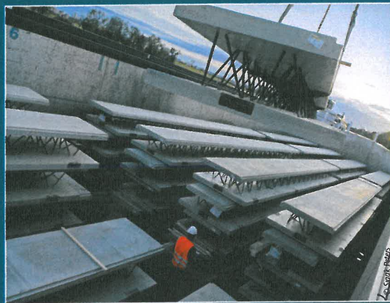
Dubbele schaal van betondelen voor flexibele doorvoer van leidingen
