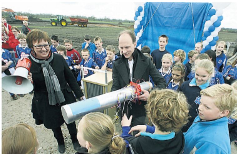
Bij het begin van de werkzaamheden in Nieuwehorne gaat een buis met tekeningen de grond in. FOTO HARRY BLOKZIJL
