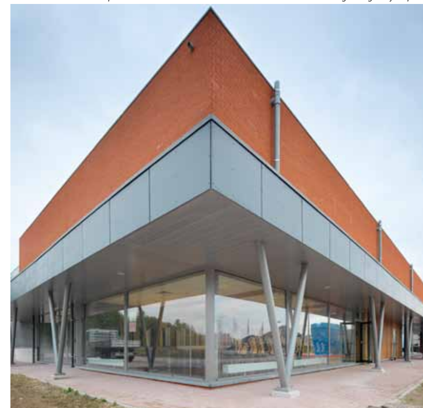
Geperforeerd metselwerk en houten constructies moeten de weerkaatsing en nagalmtijd beperken.
