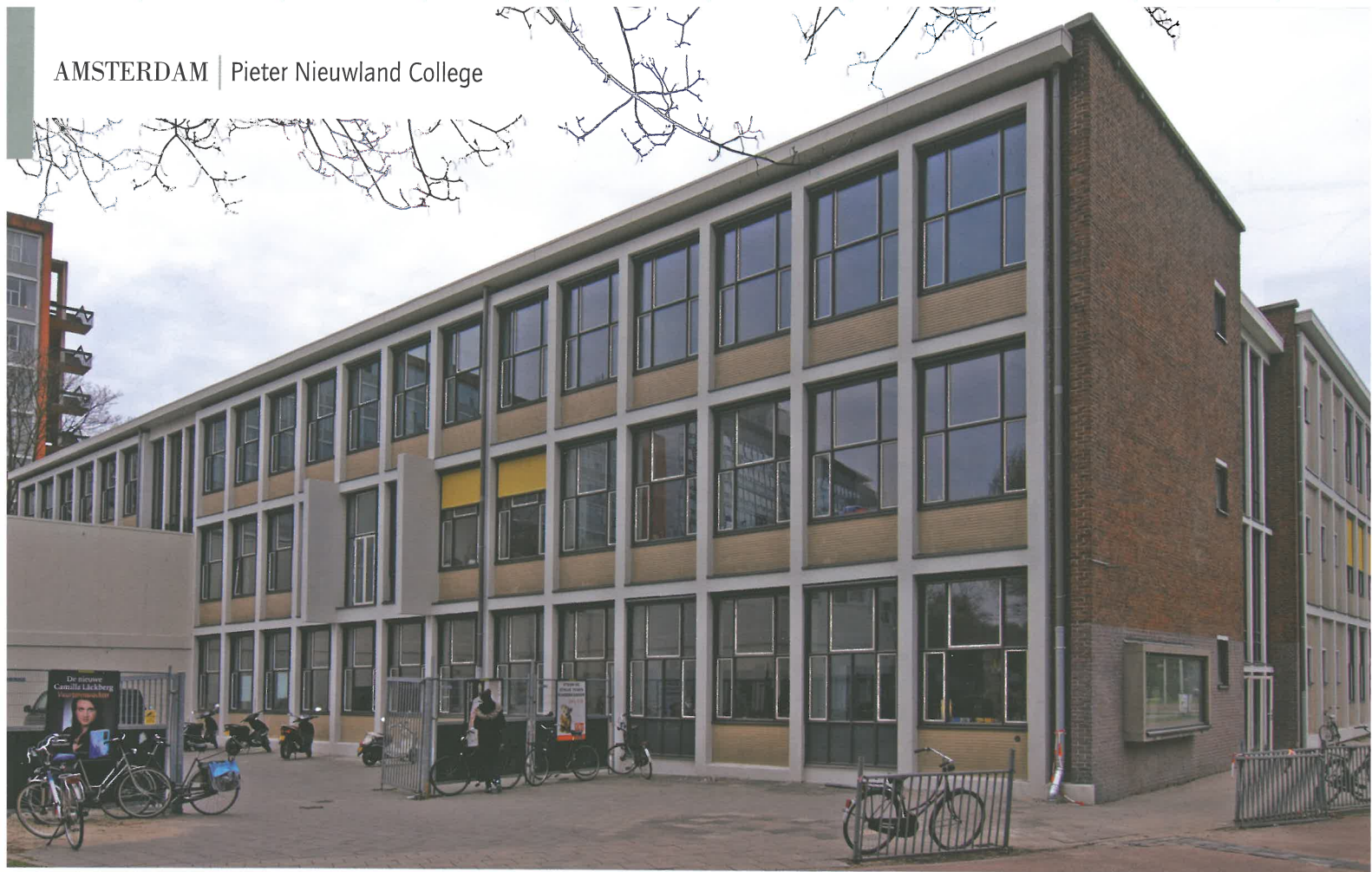
Gevels langs de Kamerlingh Onneslaan zijn gerenoveerd en energetisch opgewaarderd
