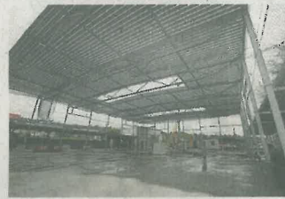
Blick in den Rohbau der Dreifach-Sporthalle.
